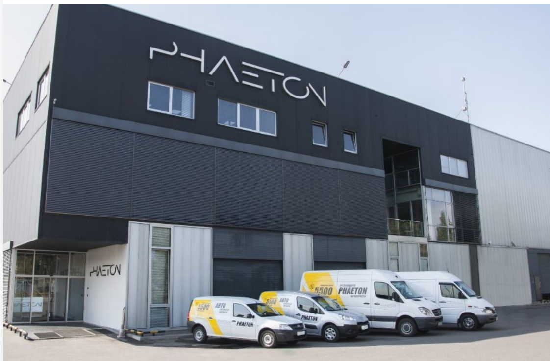
Строительство Сервисного центра Phaeton DC в Алматинской области (в том числе проектные работы)
