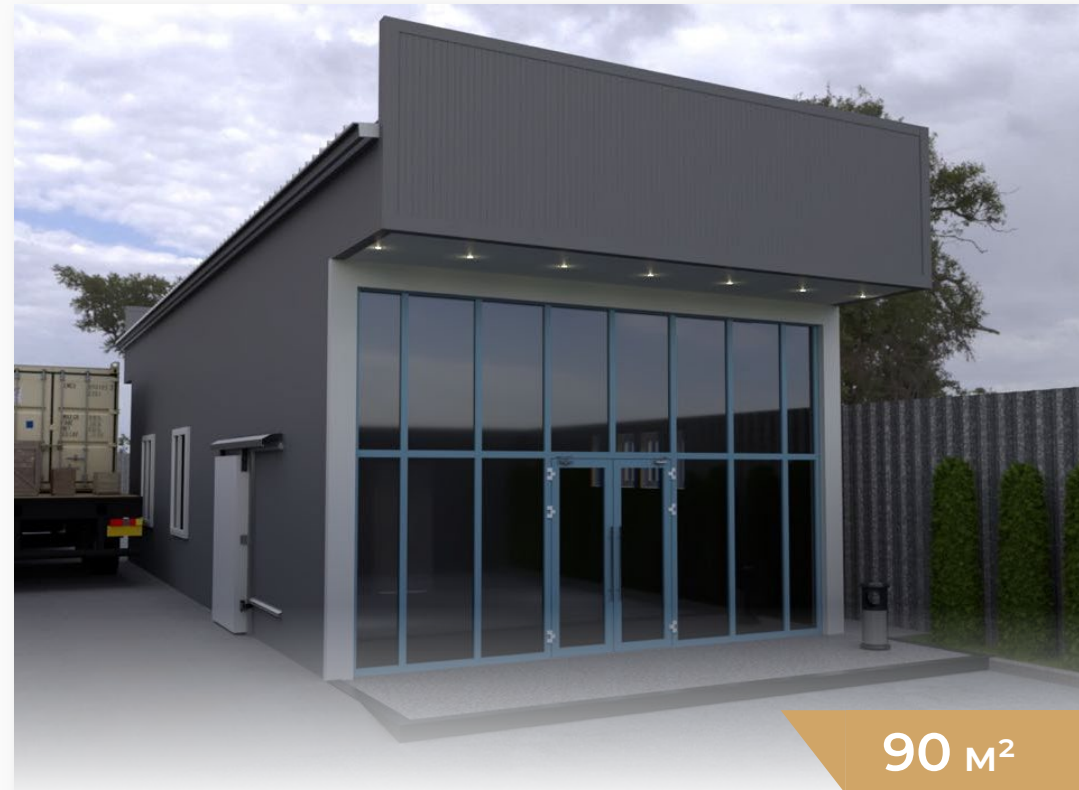
Строительство административного здания из «Сэндвич» панелей в г. Алматы
